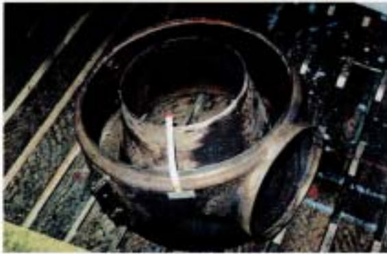
(a) 入口内部ケーシング
