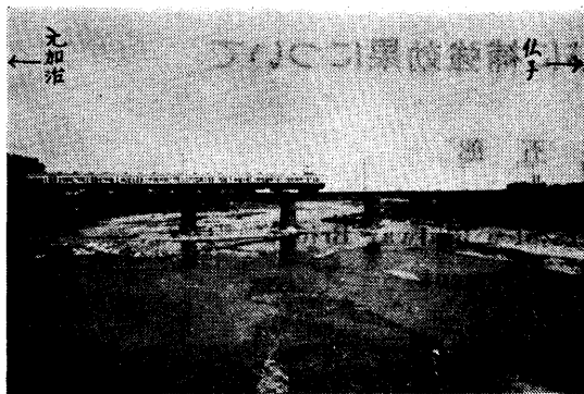
図 2 入間川鉄道橋全景および試験車
