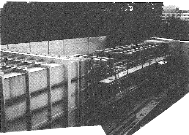
写真12 計測洞鋼製フレーム
