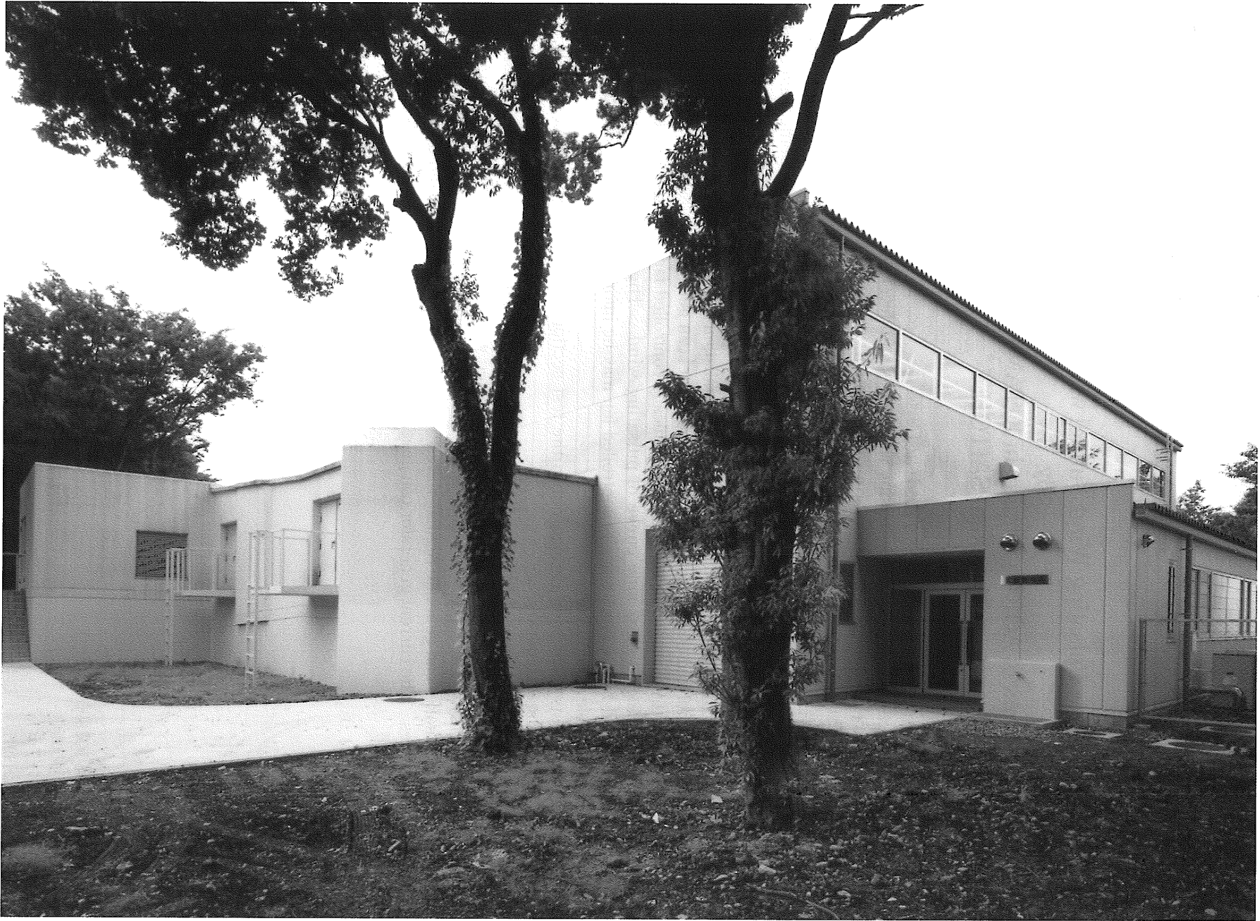
写真1 変動風水洞実験棟全景
