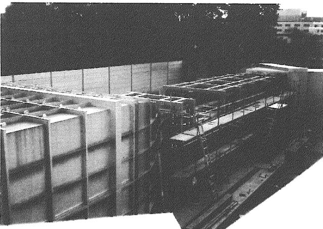
写真12 計測洞鋼製フレーム
