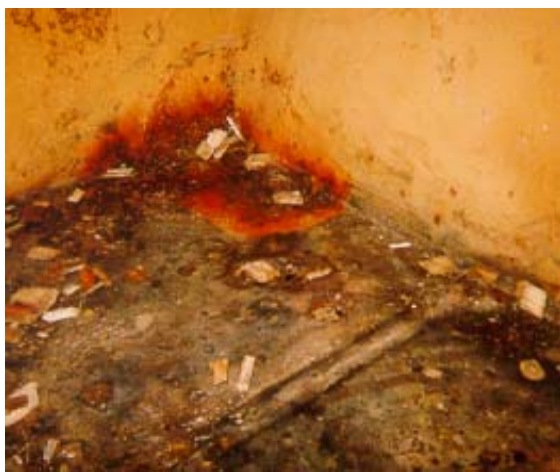
Photo.9 カーゴホールド内の亀裂 その1
