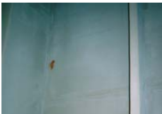
Photo.3 ケミカルタンカーのCOT内部に見られた初期の腐食
