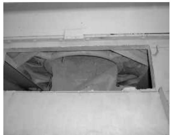
Fig.4.4.2 ホッパー投入口の状況
