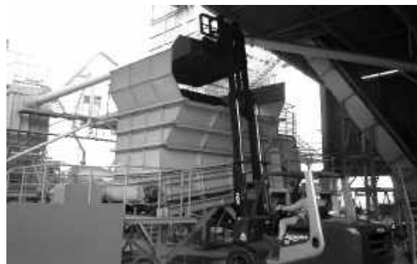
Fig.4.4.6 混合後の原材料ホッパー投入
