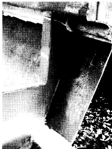
写真-33 隔壁の切断
