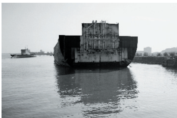
写真 7.1 解体中の船舶 広州市番禺区折船軋鋼公司
