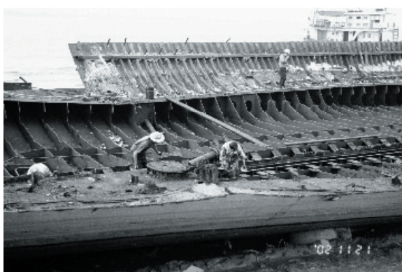
写真 7.2 船底清掃作業 新会市中新折船鋼鉄総廠
