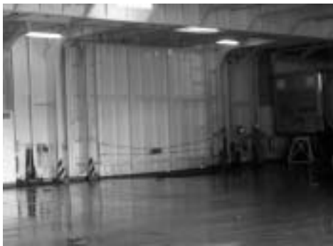
写真 C.13 船側開口部を閉鎖した状態
