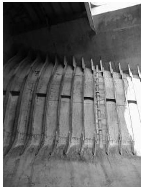
図-16 バラストタンクをホールドから見たところ（バルカーのバラストタンクは船底部と甲板近くの2カ所に分割されておりパイプで連通している。）
