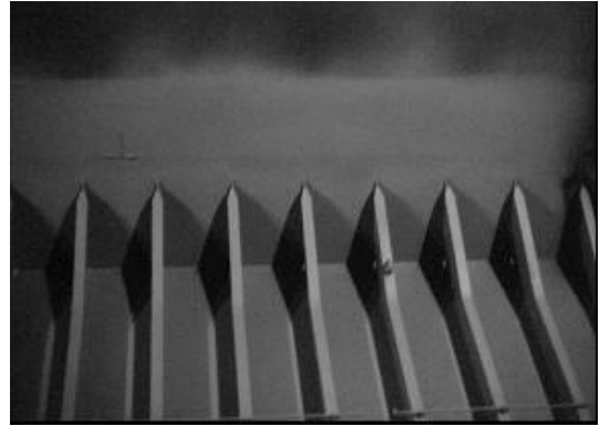
図-15 バラストタンク内部の補強材
