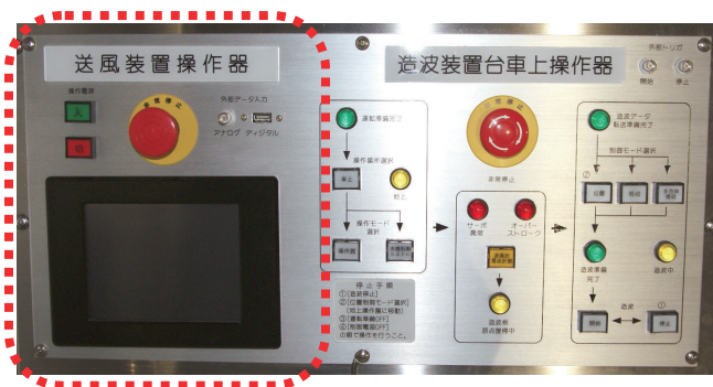
図-6.8 曳引台車操作卓上の送風装置操作器
