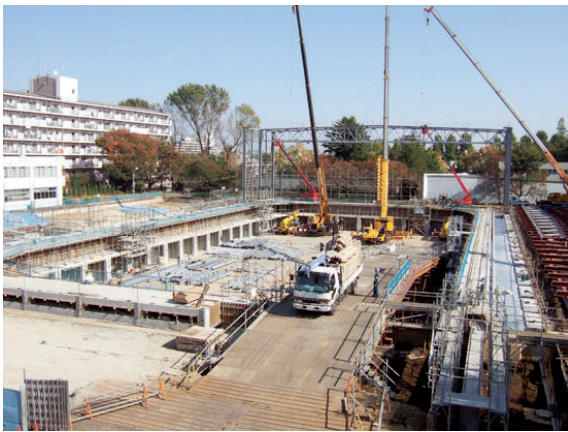
図-3.7 棟上げ中の建家(水槽南西より東を臨む)
