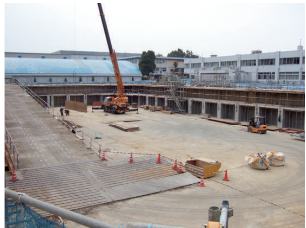
図-3.5 建設中の実海域再現水槽 (南東角より北西を臨む)
