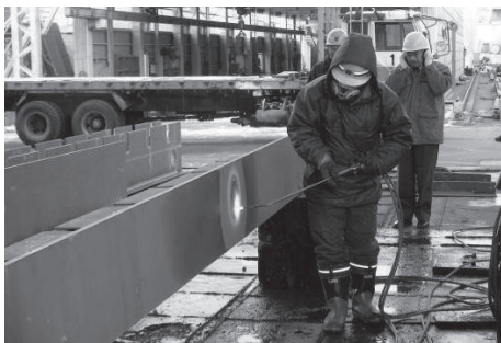
図-3.1 PCC 車両甲板トランスの逆歪施工
