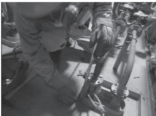
図-2.12 現場合わせ作業
