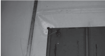
図－3.6 開口部(ドア)の歪取りの跡
