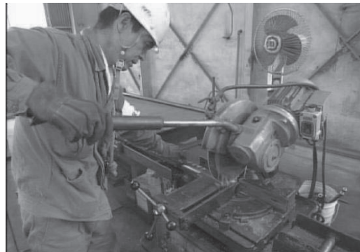
図-2.3 丸鋸による管の切断
