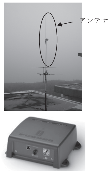
図2 アンテナ設置状況と AIS データ受信装置
