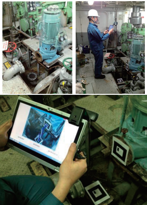
図-6 配管施工支援ARアプリケーションの使用例 (左上: 対象の現場合わせ管の様子、 右上: タブレットPCをかざして見ている様子、 下: 配管設計案のAR表示の様子)
