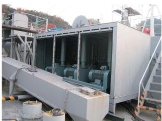
図-6.32 船上に設置したブロワー(右舷3台)<sup>18)</sup>
