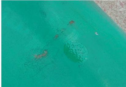
図-4.12 位置④：塗膜割れ箇所近傍
