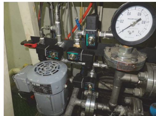
(d) 交換した電磁バルブ (2015 年 2 月)
