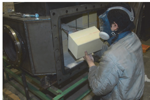
(c) 脱硝触媒の組み付け
