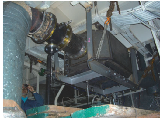
(b) 触媒反応器の外観（ラギング前）
