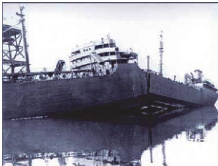
図 27 戦時標準船の Schenectady T2 tanker の脆性破壊事故 52)
