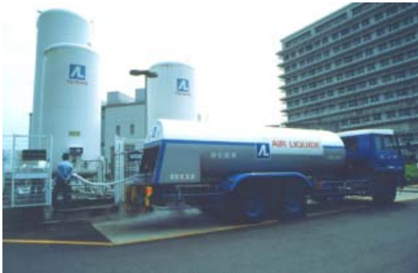
付図 1 9 定置式液化酸素貯槽（CE）へタンクローリー車より充填中 （日本医療ガス協会より提供）
