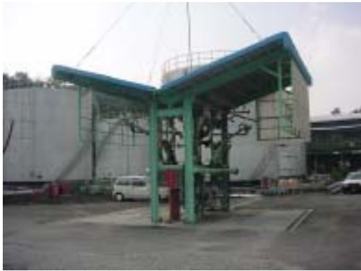
付図7 ローリー充填施設
