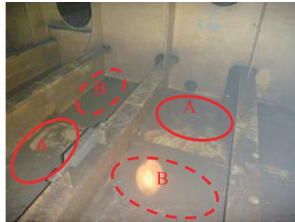
A: 凸状の変形, B: 凹状の変形
