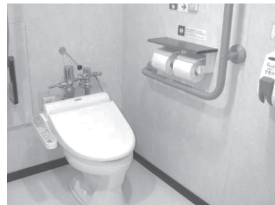
(b) トイレ(便房)内の様子 図10 バリアフリーストイレ
