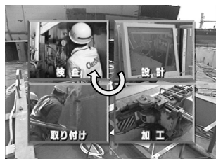
配管艤装の流れ
