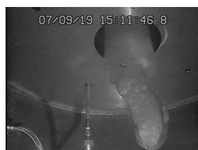
図 二重管ノズルからスラリーが投入される様子
