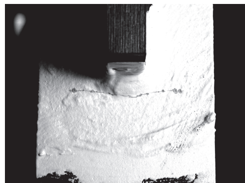
図 溶接継手止端部の疲労き裂による発色状況
