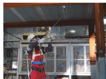
図 製作したプロトタイプを装着しての上向き作業
