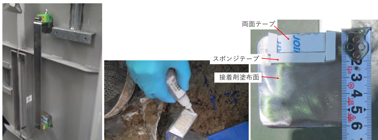
図 3.1 マグネット，瞬間接着剤，両面テープによる仮止め方法
