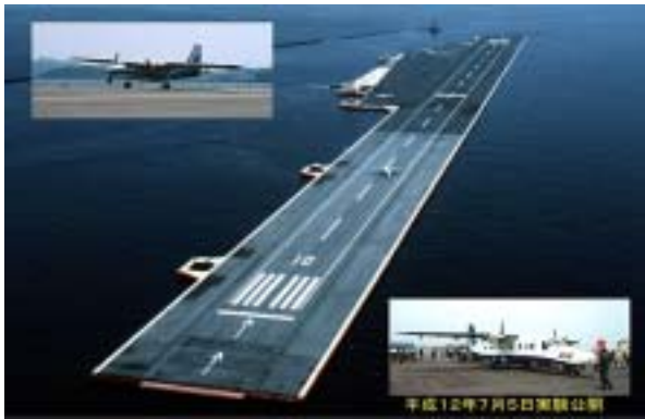
図—3 長さ1000mの実証浮体（2000年） （航空機離着陸実験）
