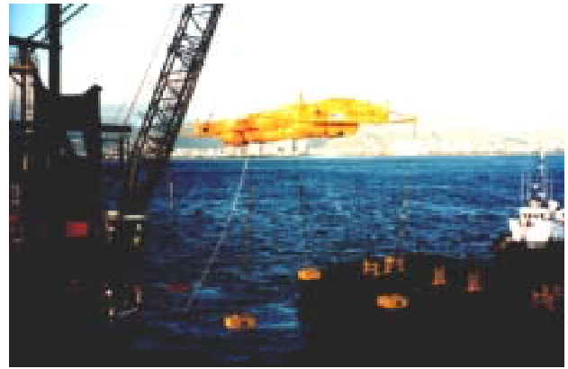
写真3 バージから降ろされる Spreader assembly
