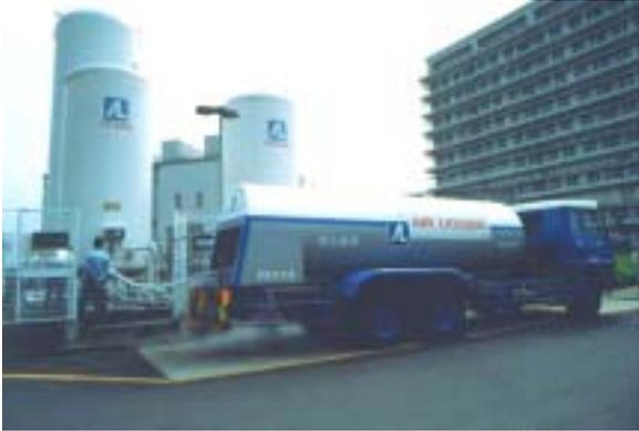
図14 定置式貯槽（CE）にローリーで充填中
