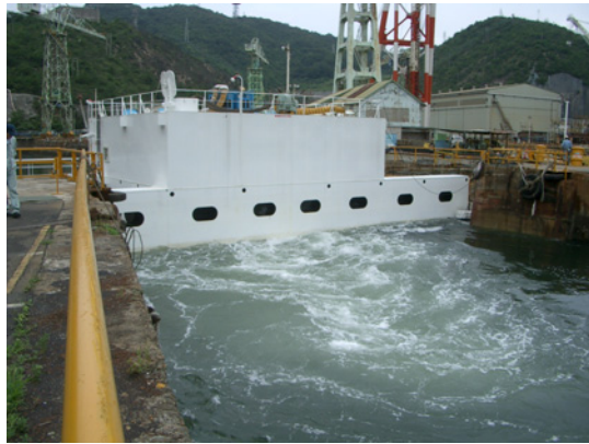
図7 電動機最大出力時のドック水面
