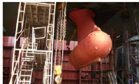
図4 ポッド本体の取り付け
