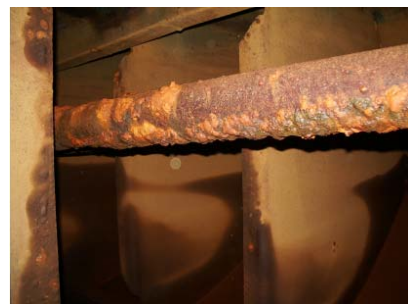
図－２ 錆の発生状況 （左）気層部のブラケット，（中）フリーエッジ部，（右）パイプ
