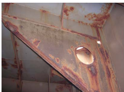
図－２ 錆の発生状況 （左）気層部のブラケット，（中）フリーエッジ部，（右）パイプ
