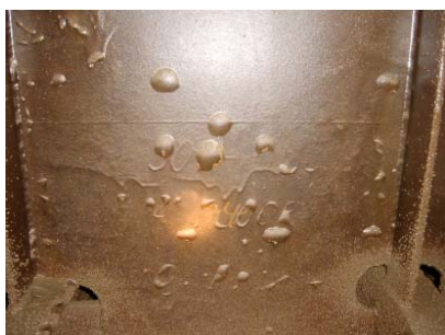
図－１ フクレの発生状況 （左）水没部仕切壁，（中）溶接線付近，（右）開口部周辺
