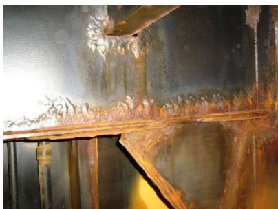
図－２ 錆の発生状況 （左）気層部のブラケット，（中）フリーエッジ部，（右）パイプ
