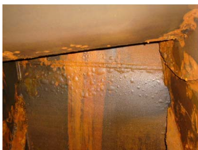
図－１ フクレの発生状況 （左）水没部仕切壁，（中）溶接線付近，（右）開口部周辺
