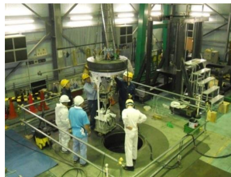
主要機器耐圧試験の様子
